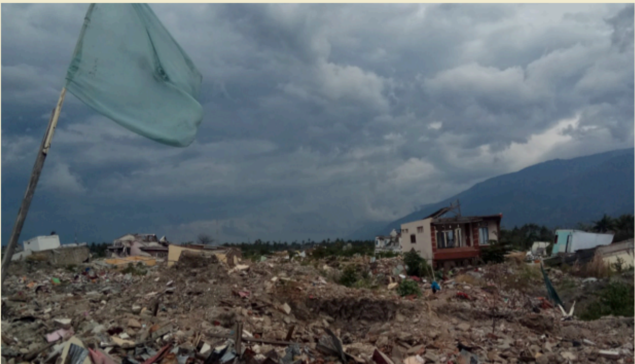
Gambar 2. Kondisi pascabencana gempa dan likuefaksi di Sulawesi Tengah
