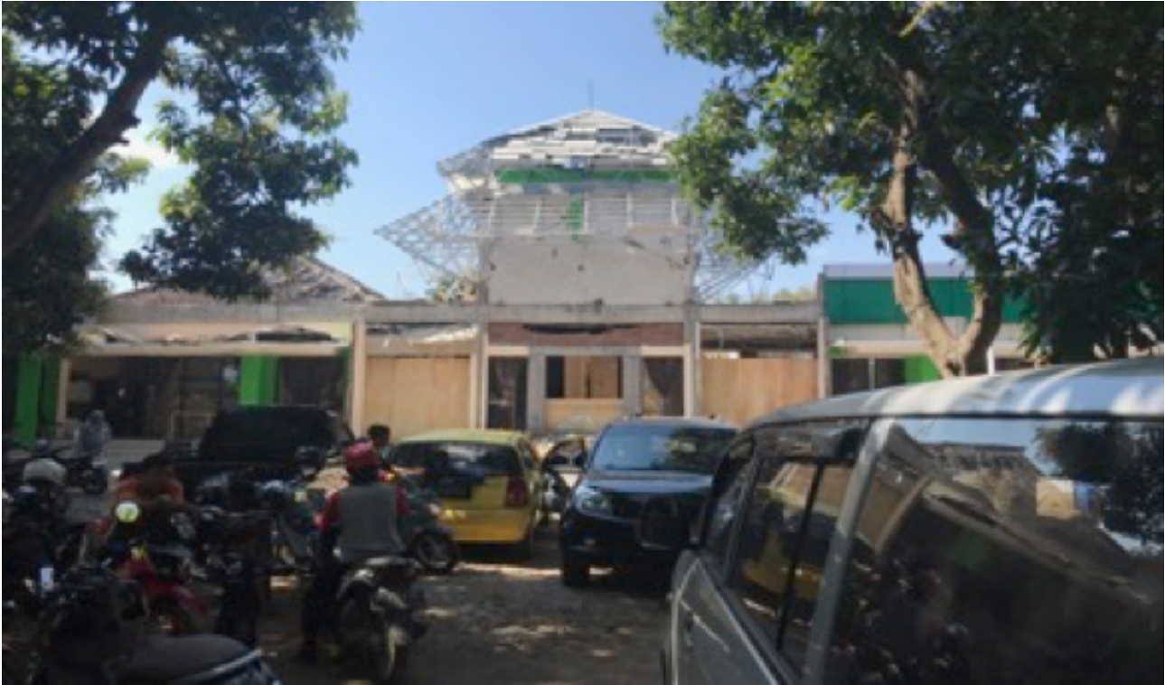
Gambar 1. Kantor Disdukcapil Lombok Utara setelah gempa
